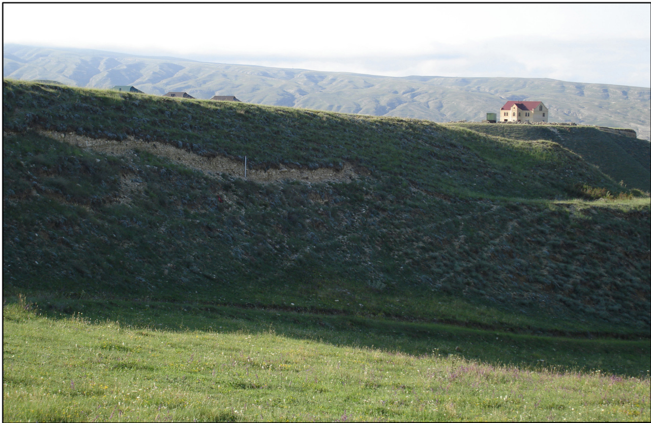
Рис. 5. Местонахождение Айникаб 6. Вид с В
